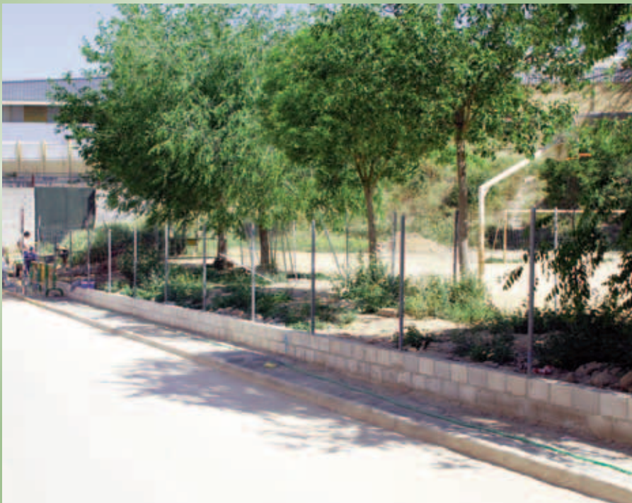
Las obras mejoran el entorno de la Cañada del Parral.
