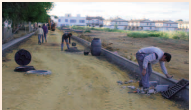
Los trabajos se encuentran muy avanzados.
