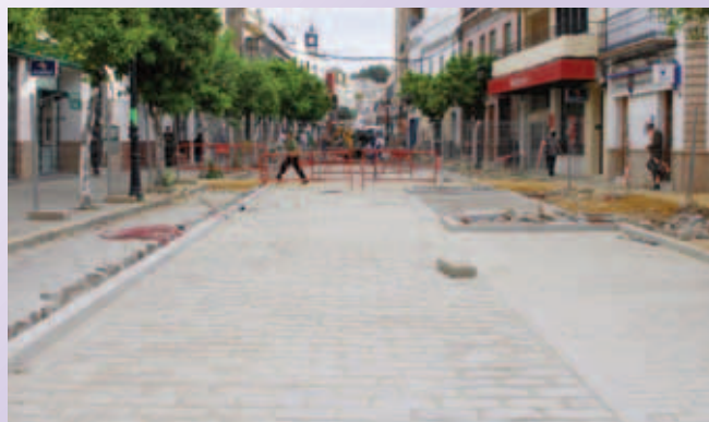
El acerado se amplía y se repavimenta la calzada.
