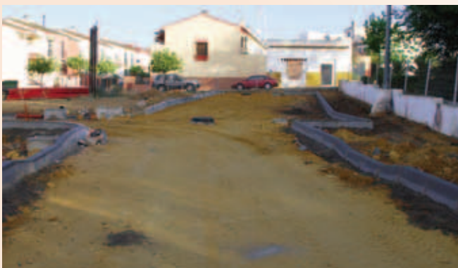
El proceso de urbanización, a punto de finalizar.
