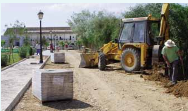
También se construye un muro de separación.
