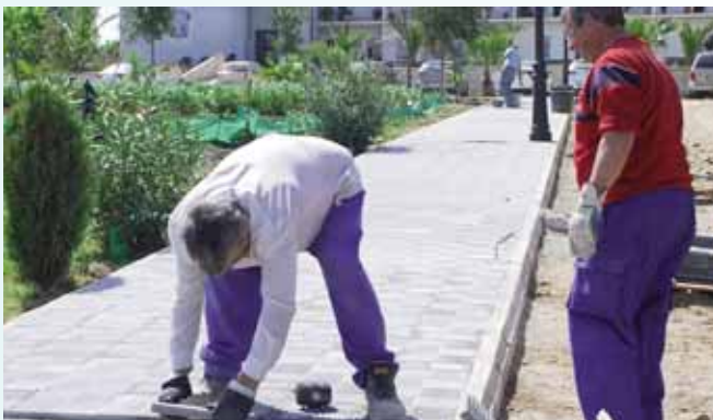
Las obras de mejora se suceden a buen ritmo.
